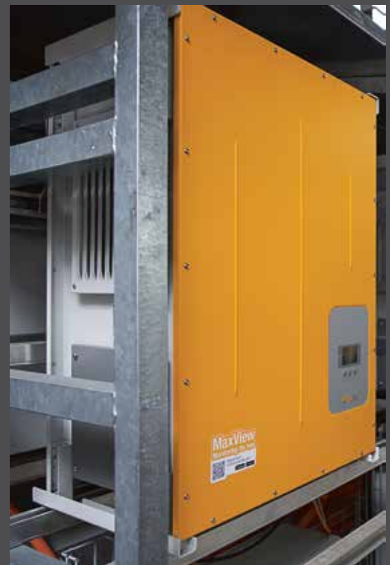
Einer der zwanzig Wechselrichter
